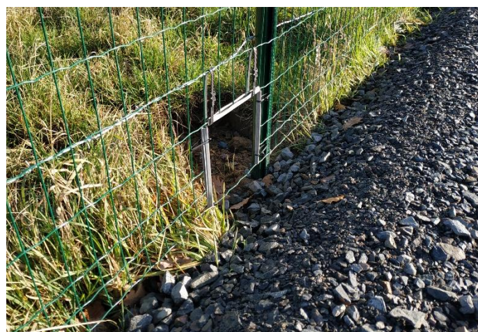
Illustration 116 : Exemple de passage à faune (Source : Cermeco)
